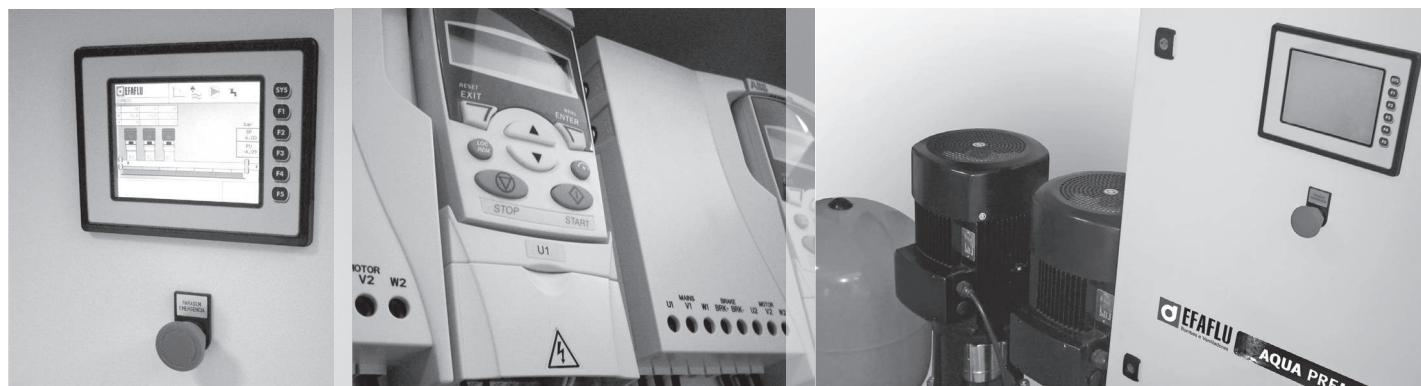
Les Groupes Aqua Premium Plus sont équipés d'un contrôleur Premium Plus avec un panneau d'affichage polychrome de 7". Ils sont préparés pour l'installation de pressostats d'urgence et/ou d'un transducteur de surpression. Il est également possible de connecter un débitmètre pour afficher la consommation instantanée et totale.
